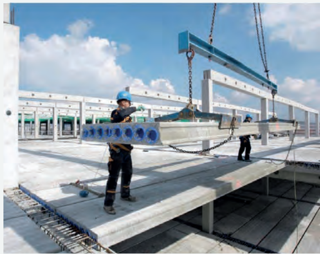
Montage einer Spannbetonhohlplatte (Foto: BVSF, Berlin)
