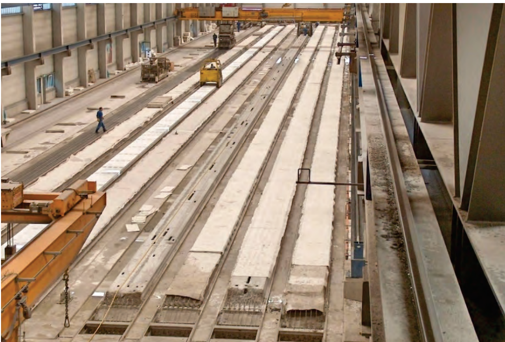
Bild 24: Herstellung von Spannbetonhohlplatten in langen Bahnen
