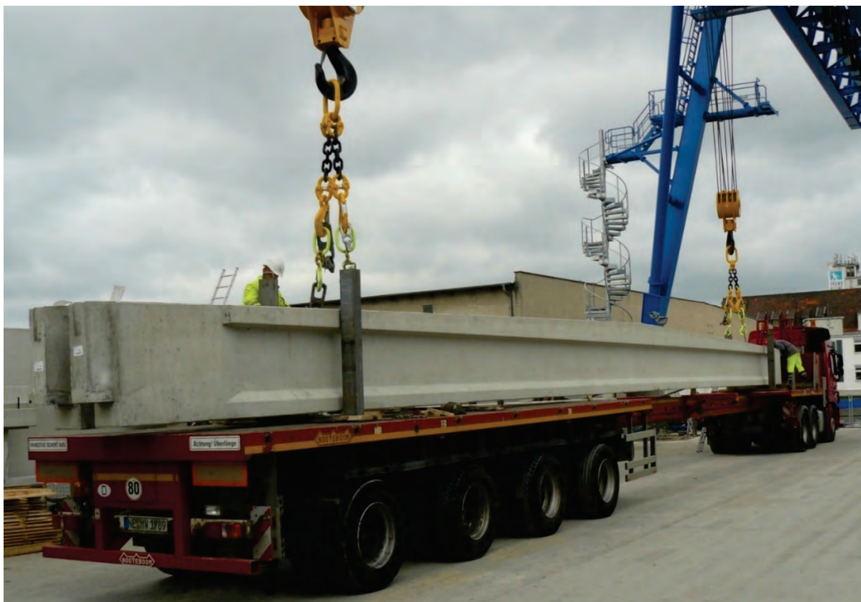
Bild 29: Transport eines Dachbinders
