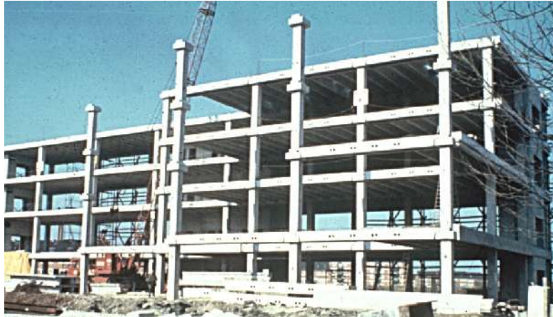
mit durchgehenden Stützen
