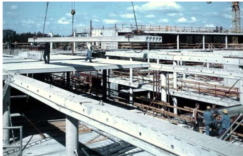
mit eingeschossigen Stützen
