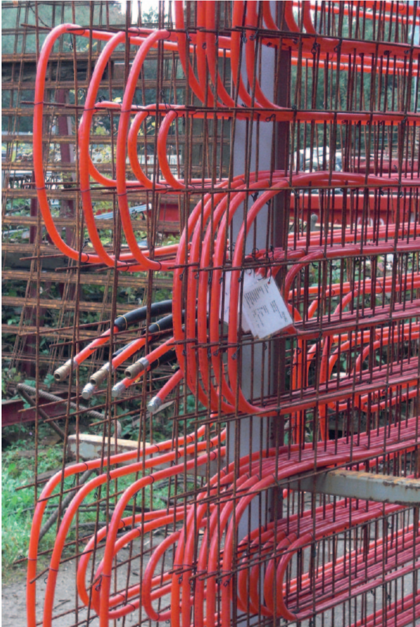
Abb. 4 (Bild oben) Vorkonfektionierte Rohrregister für die Beton- kernaktivierung ermöglichen qualitätsgeprüften Einbau im Fertigteilwerk
