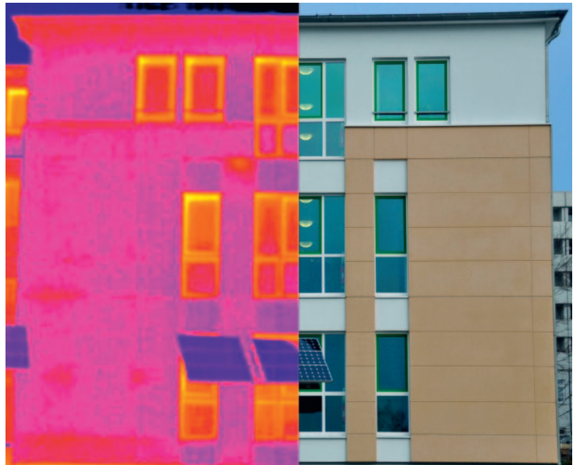
Abb. 5 (Bild oben) Thermische Optimierung der Fassade durch Stahlbeton-Sandwichelemente
