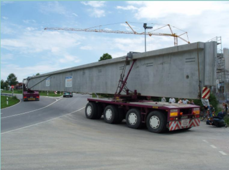
Transport eines Fertigteilbinders mit Zugmaschine mit Nachläufer. [Quelle: FDB, Broschüre Betonfertigteile im Geschoss- und Hallenbau, 2009]
