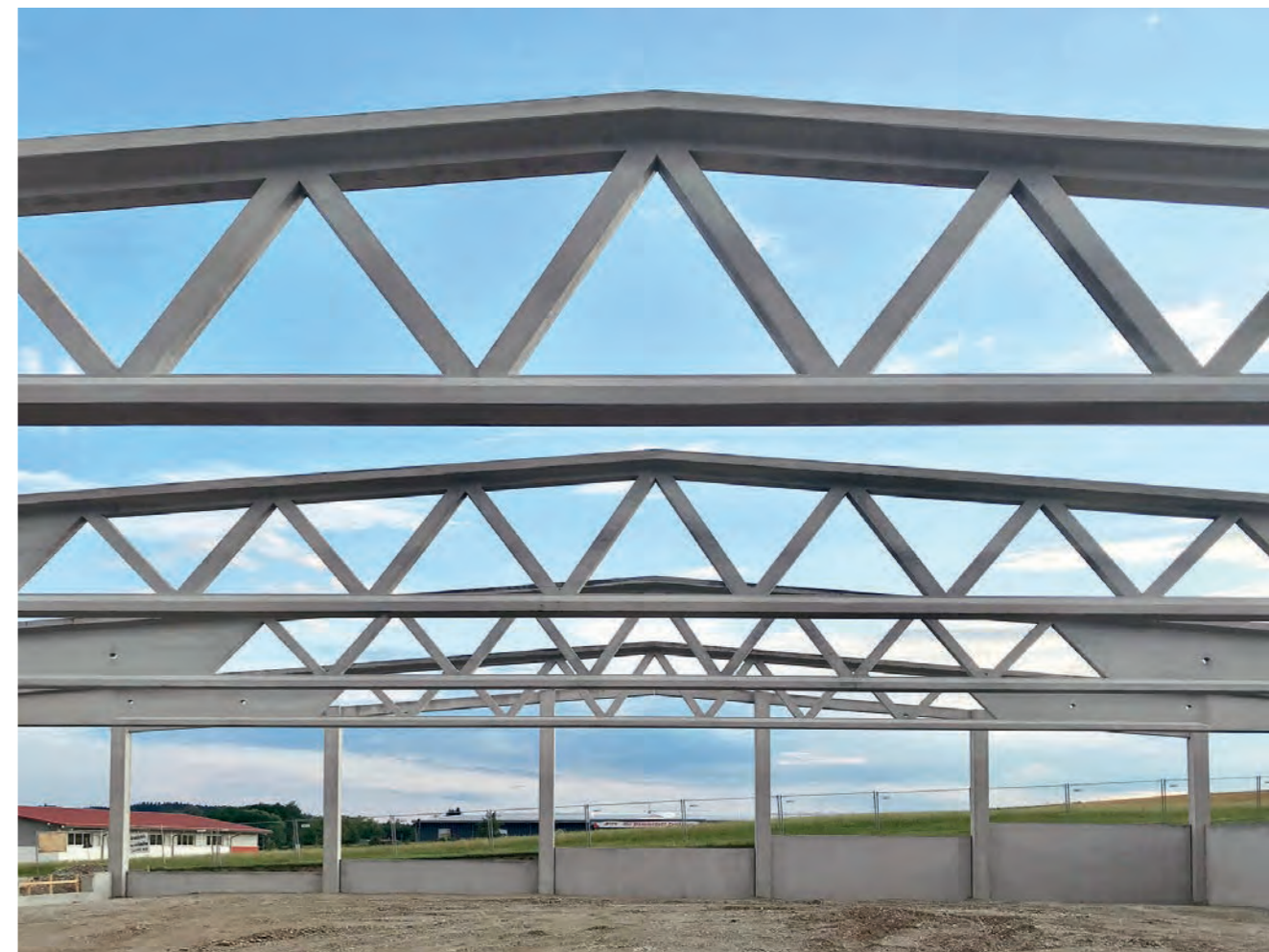
Diese Fachwerkbinder sind in Sichtbetonqualität ausgeführt und wurden unter Beachtung von Anschlagpunkten für den Transport und die Montage sicher an die Baustelle verbracht und montiert. Foto: Laumer, Massing
