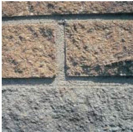
Bild 7.13: Gespaltene Betonoberfläche, heller Zuschlag, weißer Zement
