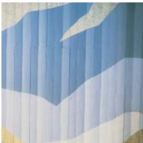
Bild 7.20: Betonoberfläche mit deckender Beschichtung, Acrylharzfarbe
