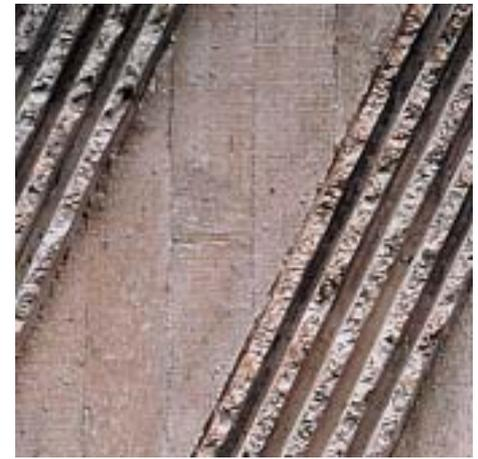
Bild 7.4: Strukturierte und raue Betonoberfläche, Reckli-Strukturschalung Nr. 1/21 Malta und sägerauer Brettschalung, Portlandölschieferzement
