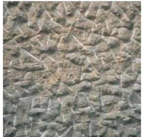
Bild 7.11: Bossierte Betonoberfläche, Kalksteinzuschlag, grauer Zement
