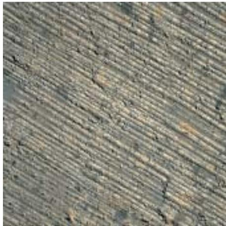
Bild 7.10: Scharrierte Betonoberfläche, farbiger Zuschlag, grauer Zement
