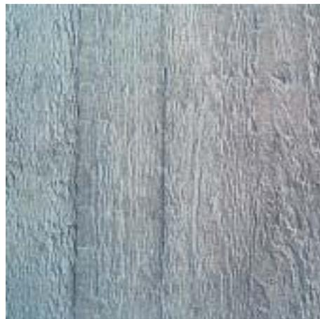
Bild 7.2: Raue Betonoberfläche, sägeraue Brettschalung, grauer Zement
