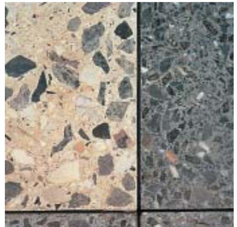
Bild 7.14: Geschliffene Betonoberfläche, heller und dunkler Zuschlag, grauer und weißer Zement
