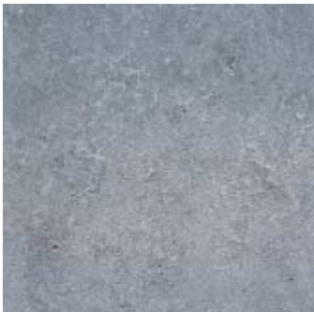
Bild 7.1: Glatte Betonfläche, Betoplanschaltung, grauer Zement
