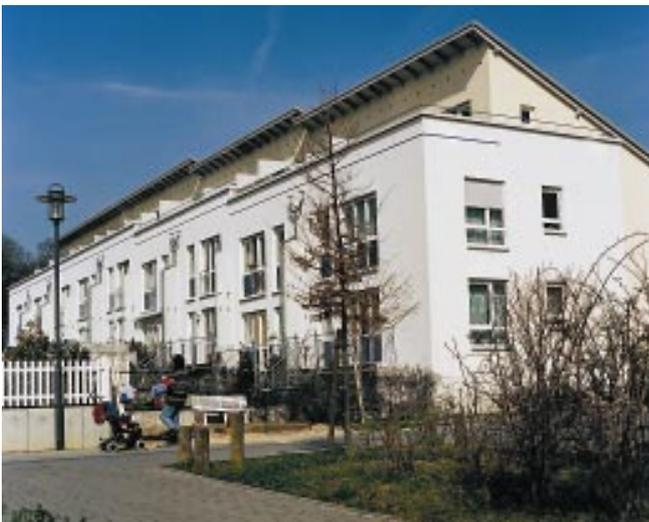
Generationshaus im Niedrigenergiestandard in Eschborn bei Frankfurt am Main, Ausführung in Betonfertigteilen mit Wärmedämmputzfassade
