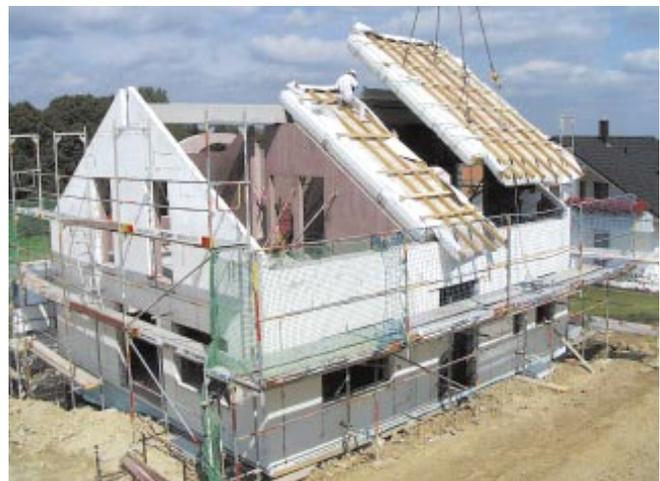
Schallschutz in ausgebautem Dachgeschoss mit Betonfertigteilelementen
