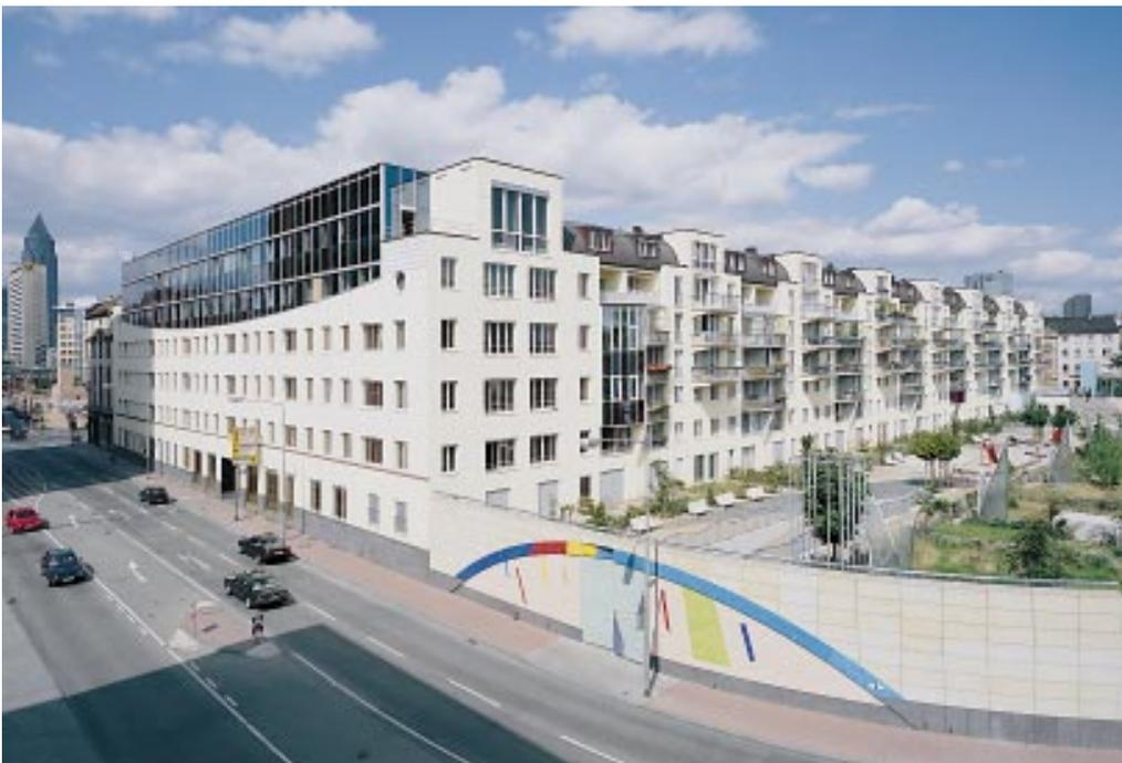
*Sozialer Wohnungsbau in Frankfurt/Main mit Bürgertreff, Büros und Tiefgarage, darauf Mietergärten; mineralische, fugenlose Putzfassade mit Wärmedämmputzsystem auf einschichtigen Stahlbetonfertigteilen*
