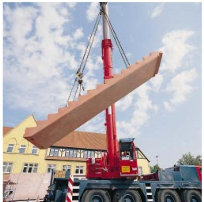
Vorgefertigter Treppenlauf mit Winkelstufen aus Beton
