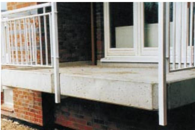
Vorgefertigte Balkonplatten bieten optimale Qualität
