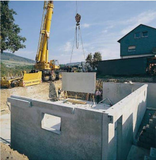
Fertigkeller für Reihenhäuser im Bauzustand
