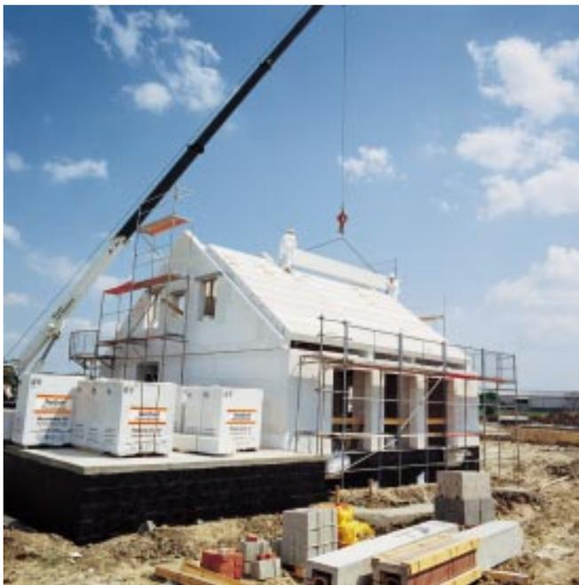
Der gesamte Rohbau besteht aus Porenbetonwandtafeln und -deckenplatten
