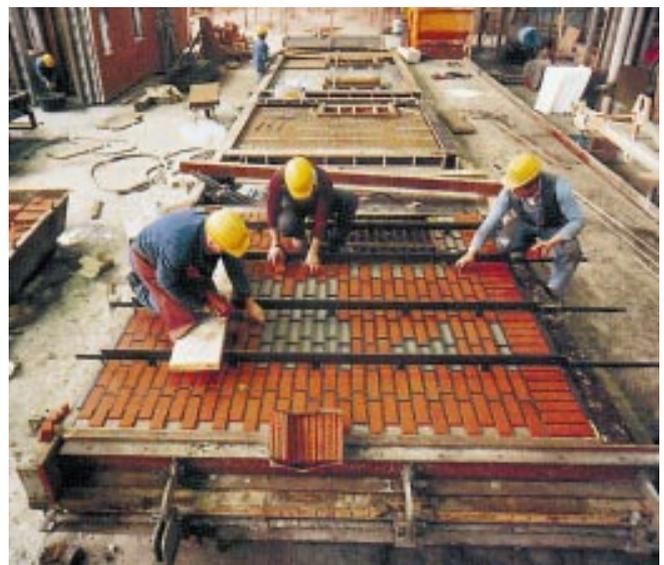
Die vorgelegten Spaltklinker werden in den frischen Beton eingelegt
