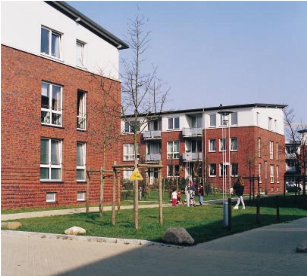
Wohnanlage in Hamburg-Allermöhe, Ausführung in Betonfertigteilen, Sockelgeschoss mit Klinkerfassade, darüber Wärmedämmputz
