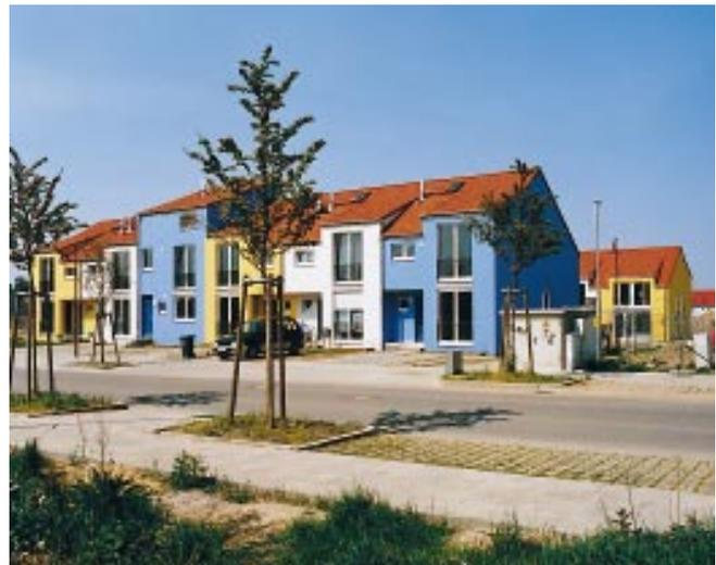
Zertifizierte Niedrigenergie-Reihenhäuser in Neuenhagen bei Berlin – Ausführung in Betonfertigteilen mit Wärmedämmputzfassaden, zum Teil mit Volltonfarbgestaltung
