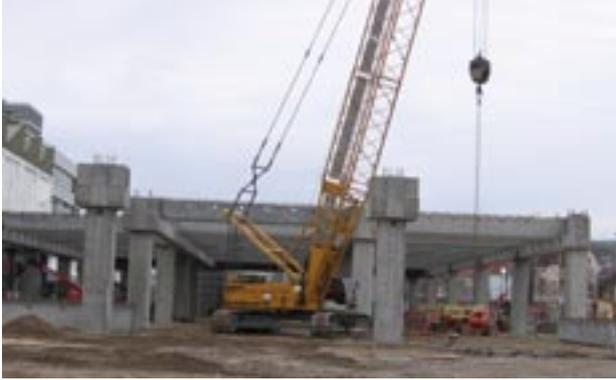
Bild 1.11: Montage mit Raupenkrane
