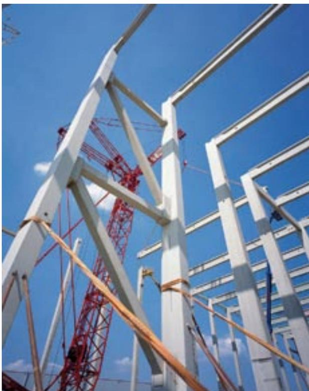
Bild 2.24: Aussteifung durch einen vertikalen Verband aus Stahlbeton-Fertigteilen
