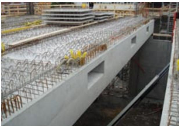
Bild 2.1 a: Elementdecken mit Halbfertigteil-Unterzug
