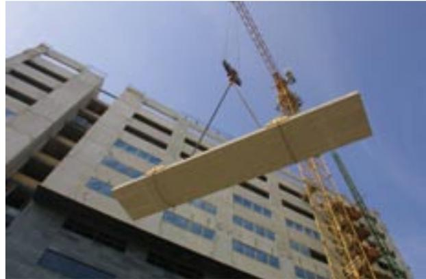
Bild 1.9: Montage einer Deckenplatte
