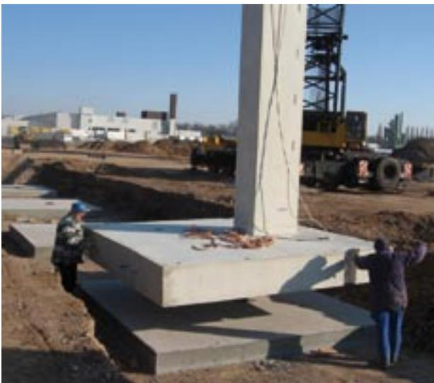
Bild 3.28: Montage eines angeformten Fundaments
