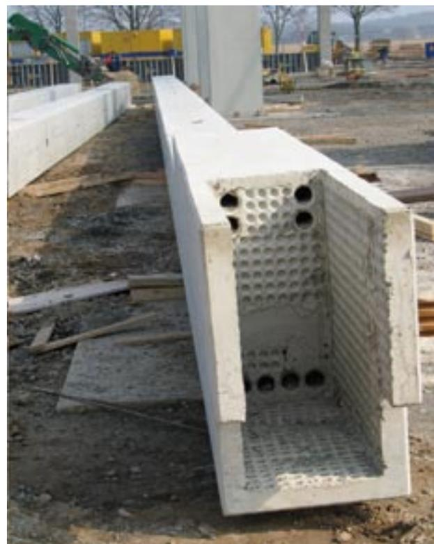
Bild 2.25: Aussteifung durch eine biegesteife Rahmenecke – Detail Stützenkopf mit Hüllwellrohren für die Gewindestangen
