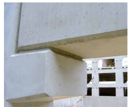
Konsolenaufleger – ein klassischer Knotenpunkt in der Betonfertigteilmontage.
